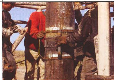
Instalación del Ademe Liso Casing Installation inside the borehole
