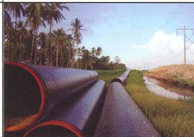
Montaje de Línea en Campo Field Line Pipe Assembly
