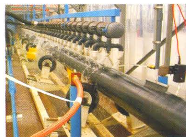
Inspección automática del Recubrimiento 3LPE 3LPE Automatic Inspection
