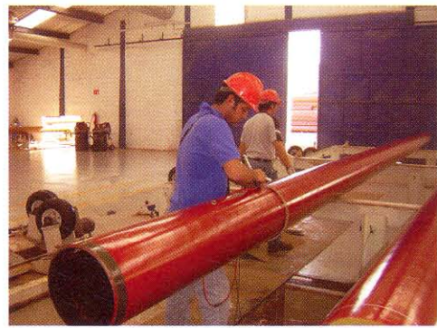
Detección de Discontinuidades del Recubrimiento Holiday Detection Test
